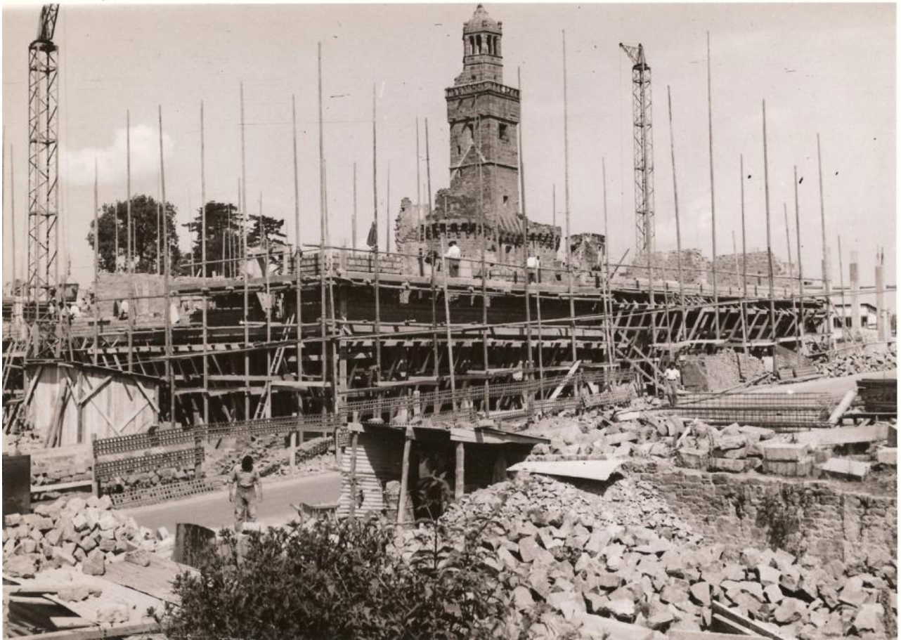
4- Chantier de l'îlot A1, vue de la rue Deslongrais, le 1 er août 1949 © Photographie Polda – Musée municipal de Vire
